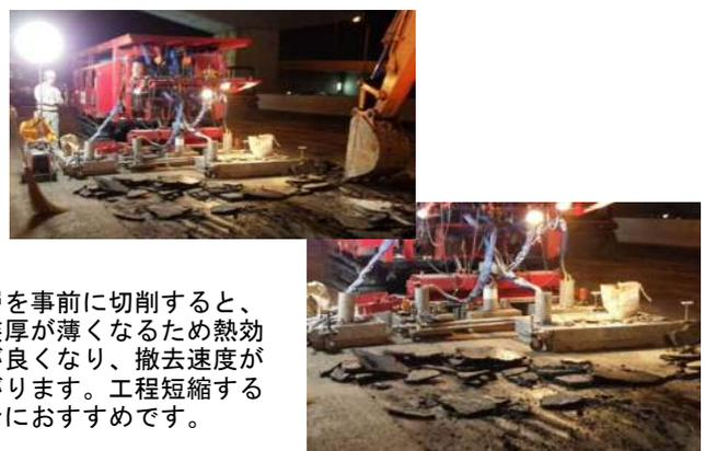
表層を事前に切削すると、舗装厚が薄くなるため熱効率が良くなり、撤去速度が上がります。工程短縮する場合作すおすすめです。
