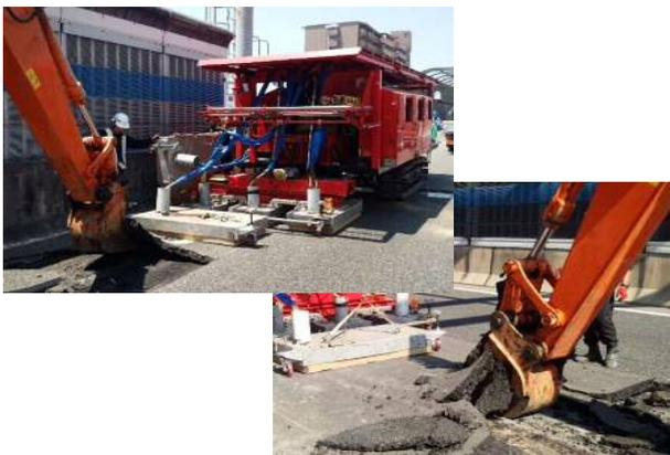
● 表層切削し基層のみ加熱・撤去状況
